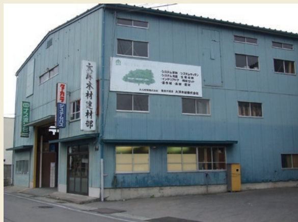
建材部 事務所と倉庫
