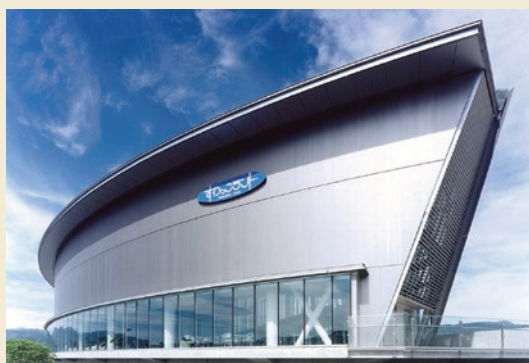
当社施工 すわっこランド外観
