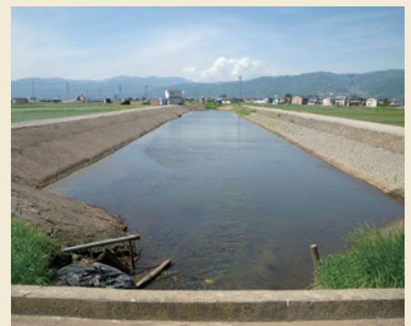
防災・安全交付金広域河川改修工事
