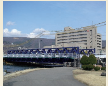
湖岸中門橋仮設道路設置工事
