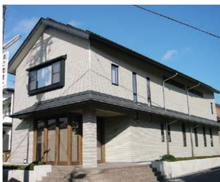
厚生棟 (食堂・研修室)
