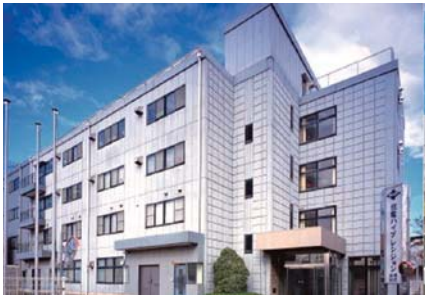
湘南本社工場
