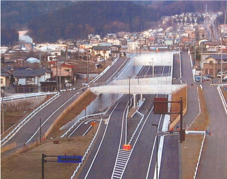
下諏訪・岡谷バイパス 横川改良工事
