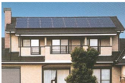
住宅用ソーラー発電システム
